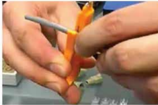
চিত্র-ওয়্যার স্ট্রিপার দিয়ে ইউটিপি কেবল(UTP Cable) এর এক মাথার উপরের আবরণটি কাটার দৃশ্য
