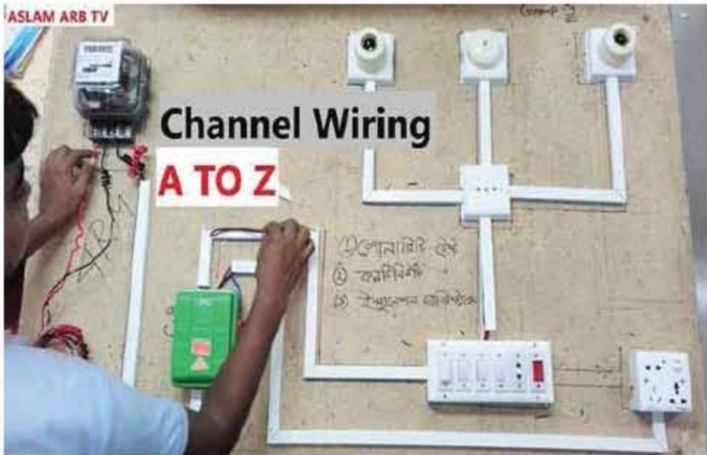
চিত্র-২.১৮ ১টি এনার্জি মিটার, ১টি মেইনসুইচ, ১টি ক্যান, ২টি বাতি ও ১টি কন্ট্রোল সকেট দিয়ে চ্যানেল ওয়্যারিং
