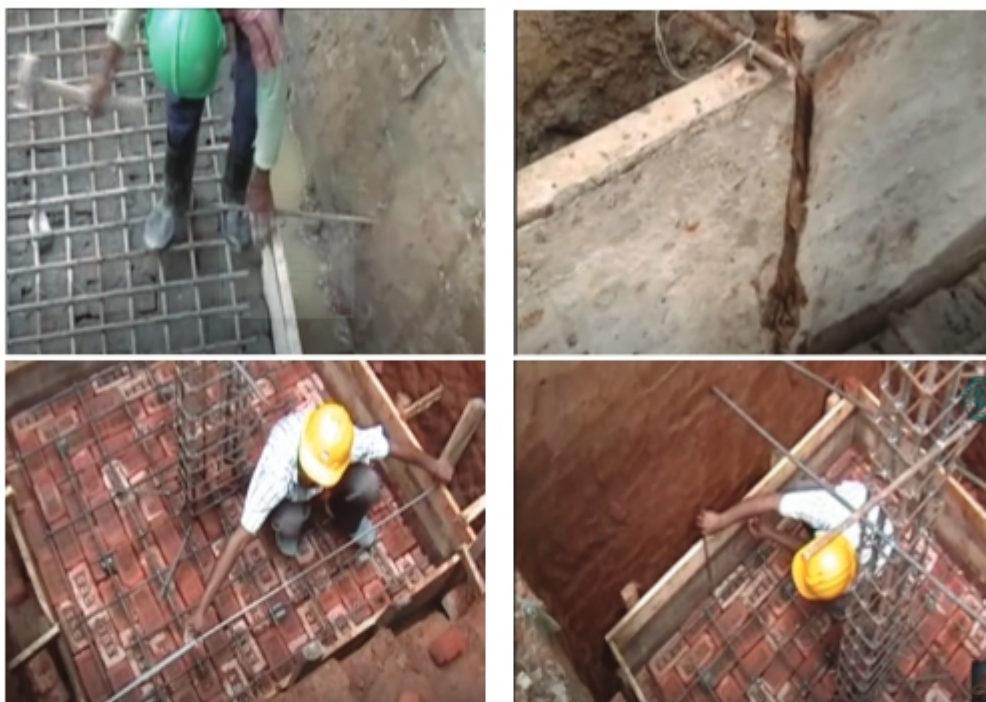
চিত্র ১.৩৭: ফর্মা স্থাপন
