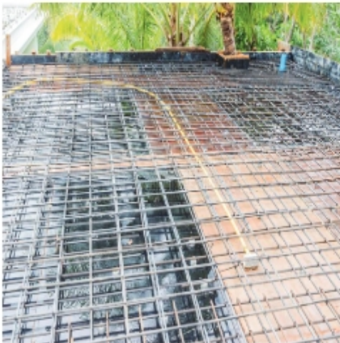
চিত্র ৪.৩৬: একমুখী ছাদের রডের বিস্তারিত
