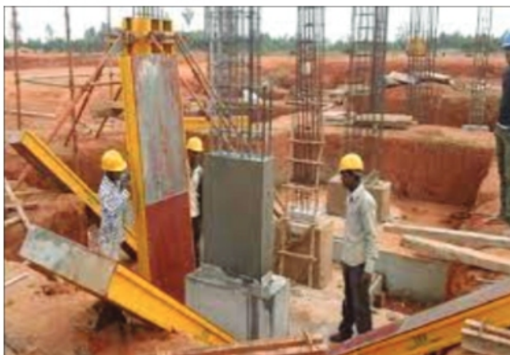
চিত্র ২.১৩: কলামের ফর্মওয়ার্ক অপসারণ
