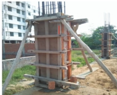
চিত্র ২.১৬: আয়তাকার কলাম তৈরিকরণ
