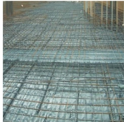
চিত্র ৪.৩৬: একমুখী ছাদের রডের বিস্তারিত
