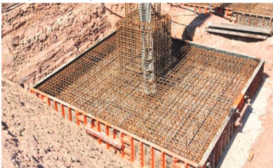
চিত্র ১.১০: ফাউন্ডেশনের ফর্মওয়ার্ক
