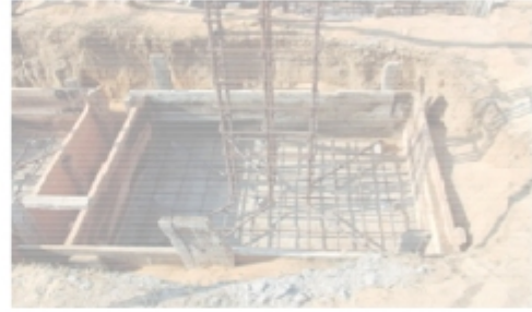
চিত্র ১.১৭: বর্গাকার ফুটিং ও ভিত্তির ফর্মওয়ার্ক
