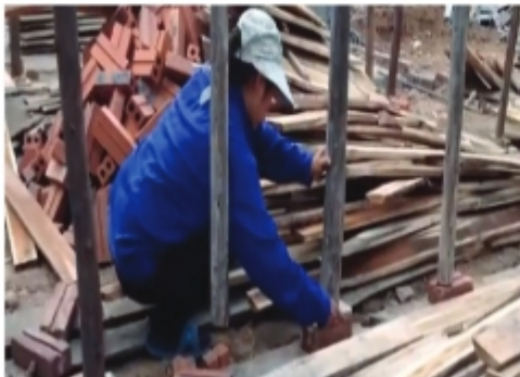
চিত্র ৪.২১: খুঁটির নিচে ইট স্থাপন
