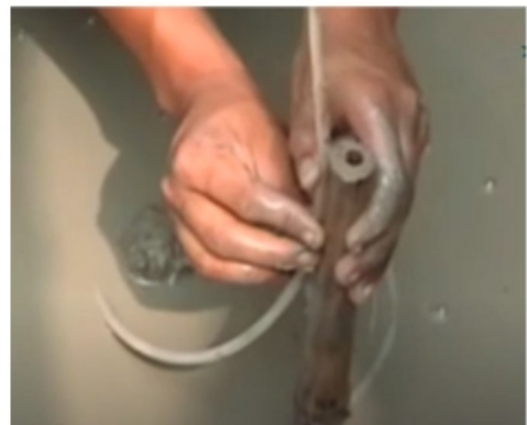
চিত্র ১.৩৩: ভিত্তি তলের সমতলতা পরীক্ষা
