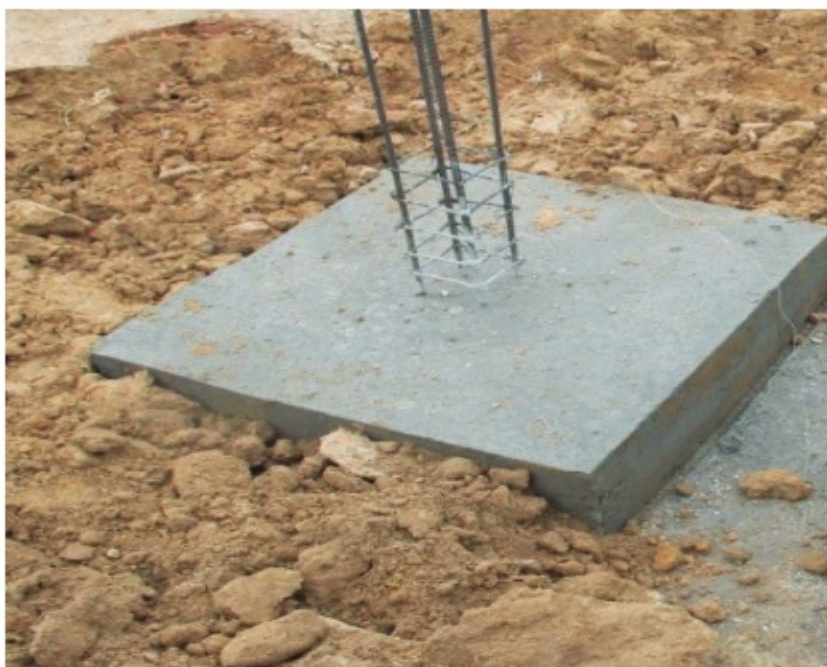
চিত্র ১.৪৮: ভিত্তির চারপাশের ফর্ম অপসারণ
