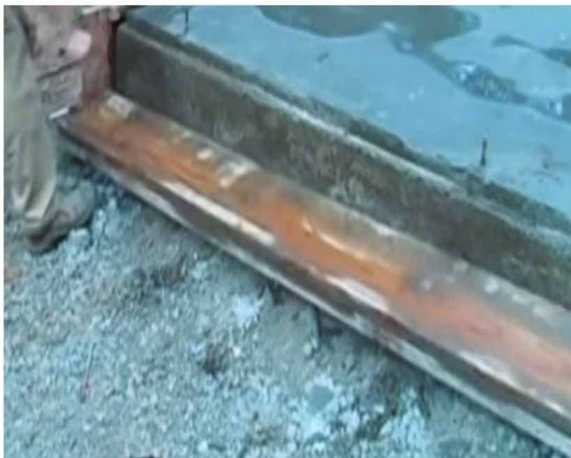
চিত্র ১.৪৭: ভিত্তির পাশের ফর্ম অপসারণ
