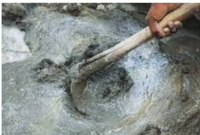
চিত্র ৪.১৯: মসলা তৈরিকরণ
