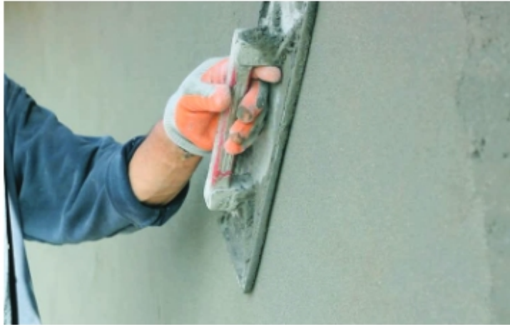
চিত্র ৪.১৫: প্লাস্টারিং কাজে পাট্টার ব্যবহার
