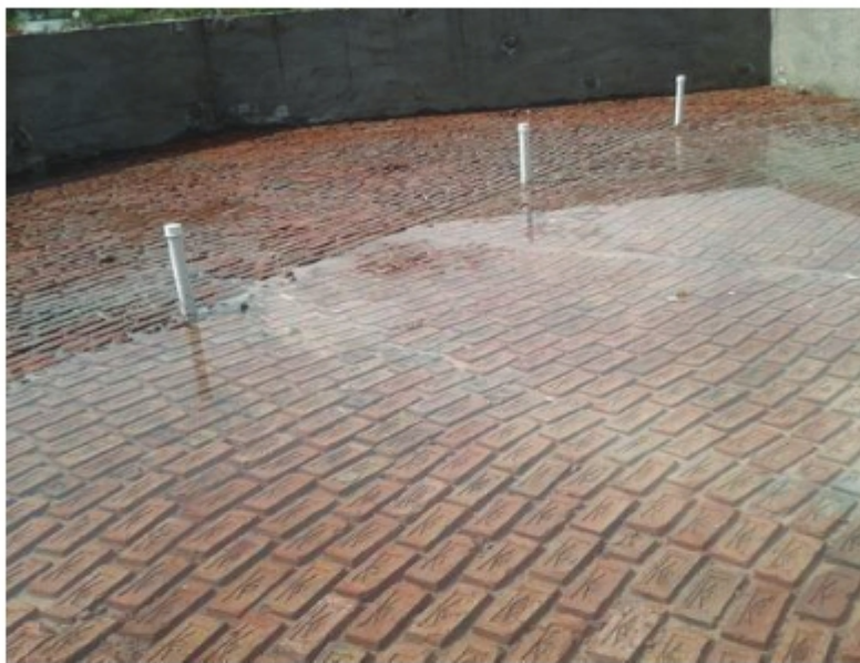
চিত্র: ৫.২ ইটের ফ্লাট সোলিং
