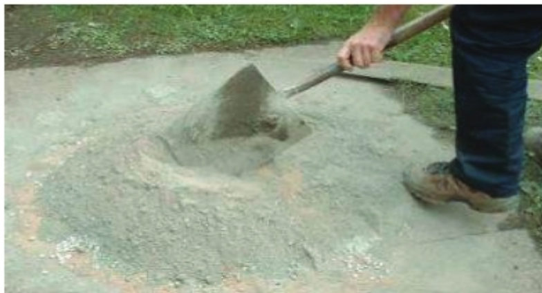
চিত্র ২.৯: মসলা তৈরিকরণ
