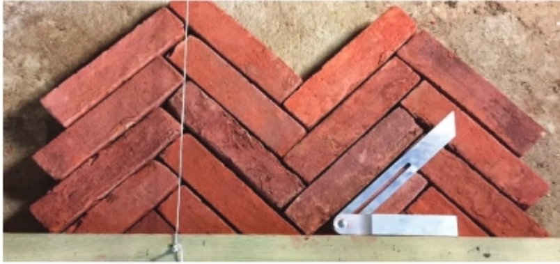
চিত্র ৫.১১: ইটের হেরিং বোন বন্ড সোলিং ব্যক্তিগত সুরক্ষা সরঞ্জাম
