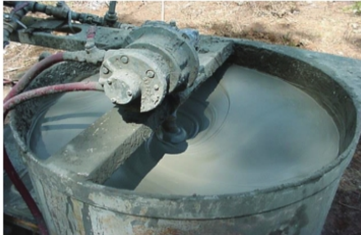
চিত্র ৬.১৩: গ্রাউটিং প্রস্তুতকরণ
