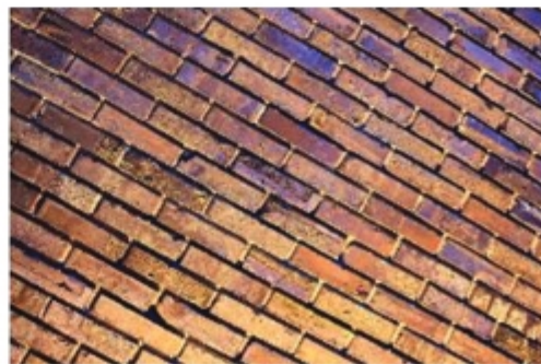
চিত্র: ৫.৩ ডায়গোনাল বন্ড সোলিং (Diagonal Bond Soling)
