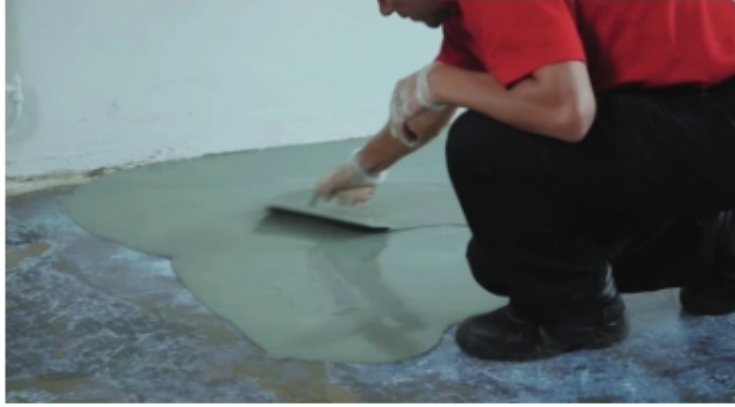
চিত্র ৬.১৮: মসলা ও সিমেন্ট গ্রাউটিং প্রয়োগে বেড তৈরিকরণ
