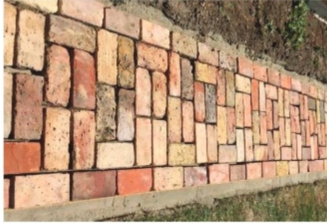
চিত্র ৫.১: ইটের সোলিং (Brick Soling)
