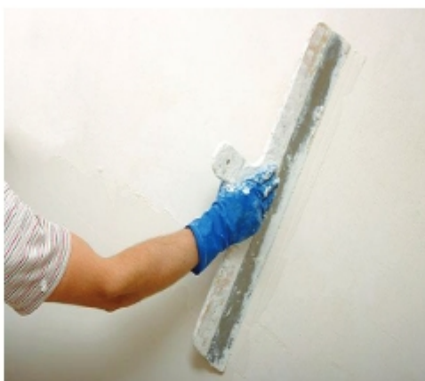
চিত্র ৪.২৯: আরসিসি সারফেসে প্লাস্টার মসৃণকরণ
