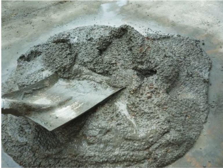
চিত্র ৪.৪: মসলা তৈরিকরণ
