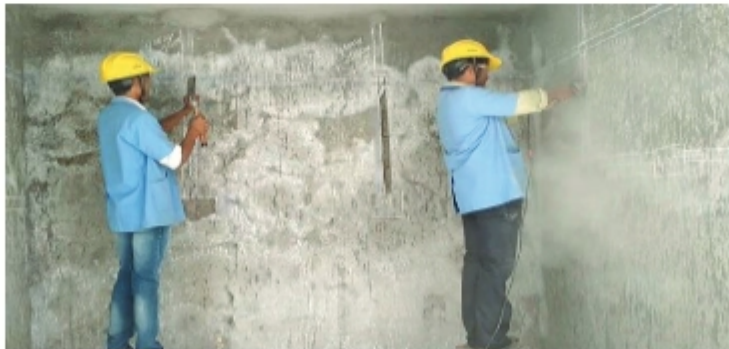
চিত্র ৪.২৬: আরসিসি সারফেস চিপিংকরণ
