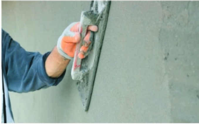
চিত্র ৪.১৩: প্লাস্টারিং কাজে পাট্টার ব্যবহার
