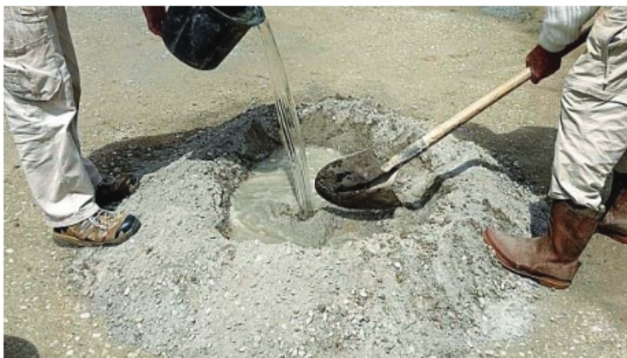
চিত্র ৪.৬: মসলা তৈরিকরণ
