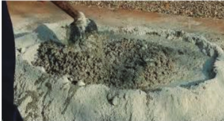
চিত্র ৬.১৬: মসলা তৈরিকরণ
