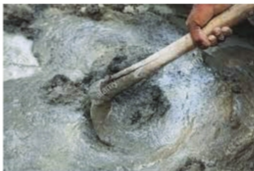
চিত্র ১.৩৮: মসলা তৈরিকরণ (অনুপাত ১:৬)
