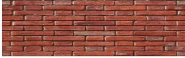
চিত্র ১.৫০: স্ট্রেচার বন্ড
