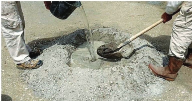
চিত্র ১.৩৭: মসলা তৈরিকরণ (অনুপাত ১:৫)
