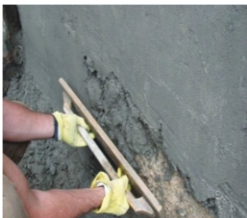
চিত্র ৪.২৯: আরসিসি সারফেসে প্লাস্টার মসৃণকরণ
