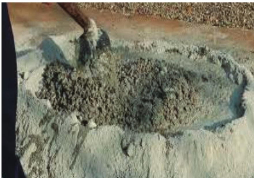
চিত্র ৩.১৪: মসলা তৈরিকরণ
