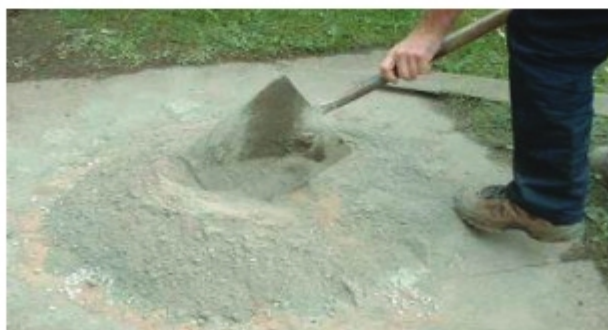
চিত্র ৪.৭: মসলা তৈরিকরণ
