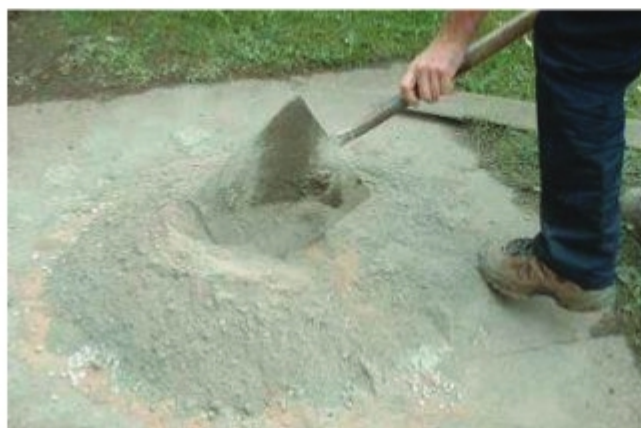
চিত্র ১.৩৬: মসলা তৈরিকরণ (অনুপাত ১:৪)
