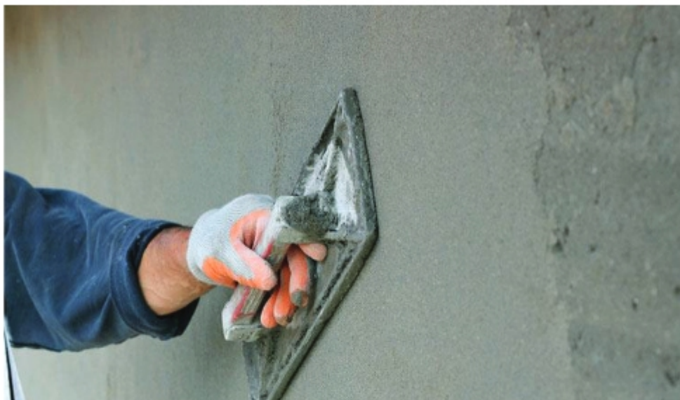
চিত্র: ৪.২৫ আরসিসি পৃষ্ঠে প্লাস্টার
