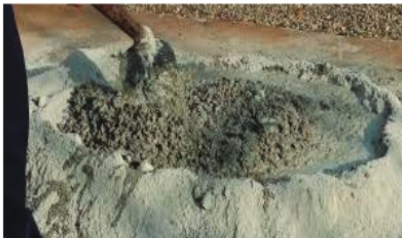
চিত্র ৪.৫: মসলা তৈরিকরণ
