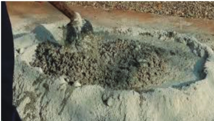
চিত্র ১.৫৬: মসলা তৈরিকরণ
